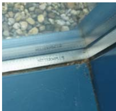
Označenie izolačných skiel na: a – sklápacích oknách; b – pevných oknách.
