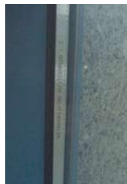
Označenie izolačných skiel na: a – sklápacích oknách; b – pevných oknách.
